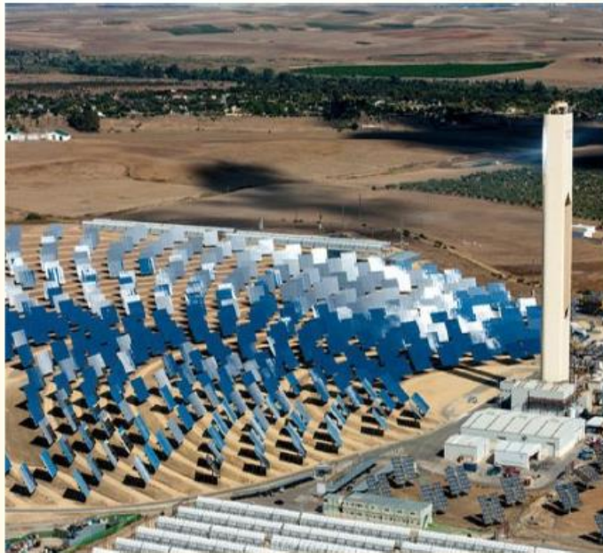
Planta Termosolar de Torre. Abengoa. Sevilla.
